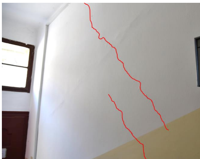
Slika 22. – Prikaz oštećenja uličnoga južnog stubišnog zida (lijevo) i nadvoja unutarnjeg zida u stambenom prostoru (desno)
