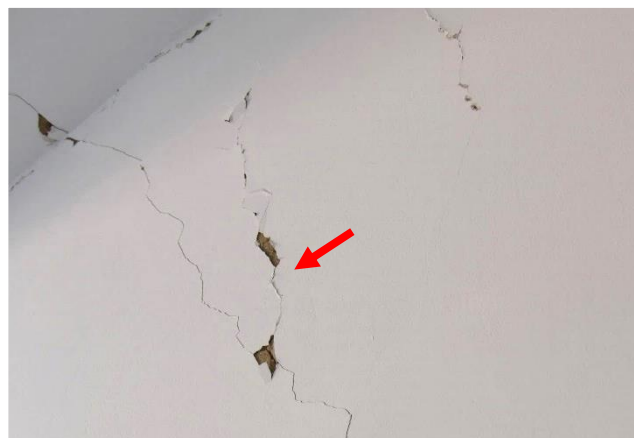
Slika 14. – Oštećenje južnoga zabatnog zida (lijevo), vidljive pukotine stubišnog zida (desno)
