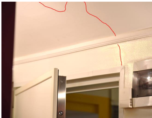
Slika 26. – Prikaz manjih oštećenja (pukotina) nadvoja zidova u podrumu
