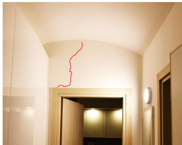
Slika 26. – Prikaz manjih oštećenja (pukotina) nadvoja zidova u podrumu
