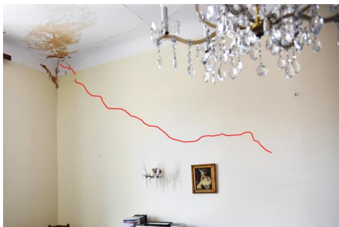
Slika 14. – Oštećenje južnoga zabatnog zida (lijevo), vidljive pukotine stubišnog zida (desno)
