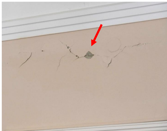
Slika 22. – Prikaz oštećenja uličnoga južnog stubišnog zida (lijevo) i nadvoja unutarnjeg zida u stambenom prostoru (desno)
